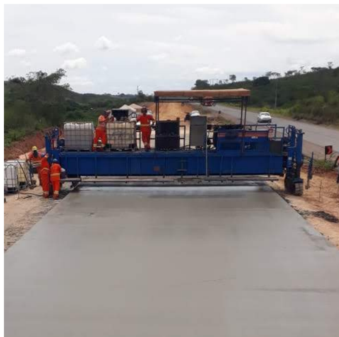
Aplicação de pavimento rígido com tecnologia MOBA Foto: cedida pelo entrevistado, Waldir Soares
